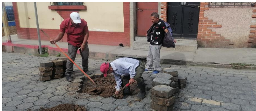
Reparacion en 5ta avenida , Cabecera Central – 5 de Octubre del 2024
